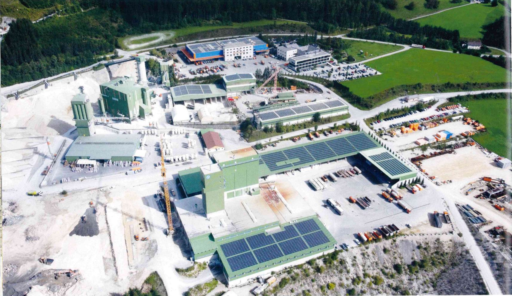
Die Zentrale der Firma Bernegger in Molln, die ca. 1.000 Mitarbeiterinnen und Mitarbeiter beschäftigt.
